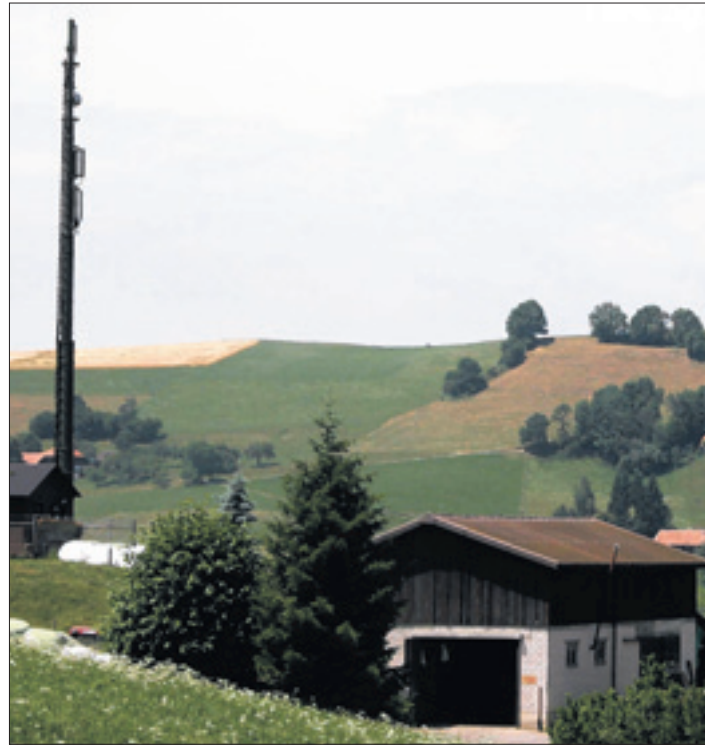
Eine Anpassung der Entschädigung drängt sich bei Ablauf der Verträge oder bei Aufrüstung der Anlagen auf. (Bild grü)
