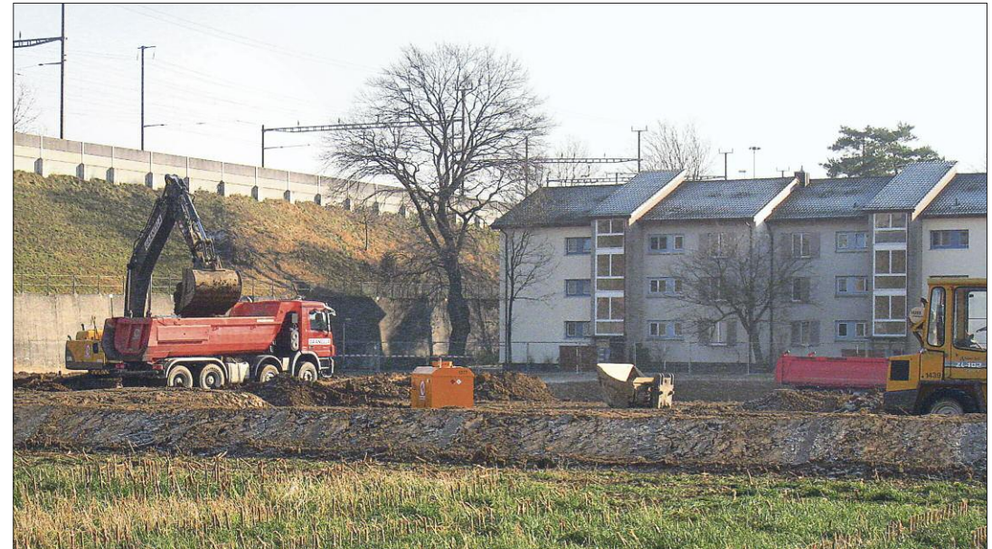
Hier ist es zu spät zum Steuern sparen. Dieses Stück Land in Brugg, wo am vergangenen 18. Januar die Baumaschinen arbeiteten, ist definitiv nicht mehr dem bauerlichen Bodenrecht unterstellt. (Bild Hans Rüssli)
