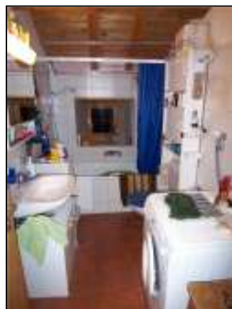
Grundstück Nr. 244 Wohnhaus: Bad
